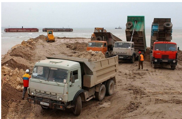
Жовтень 2003. Будівництво дамби до українського острова Тузла
